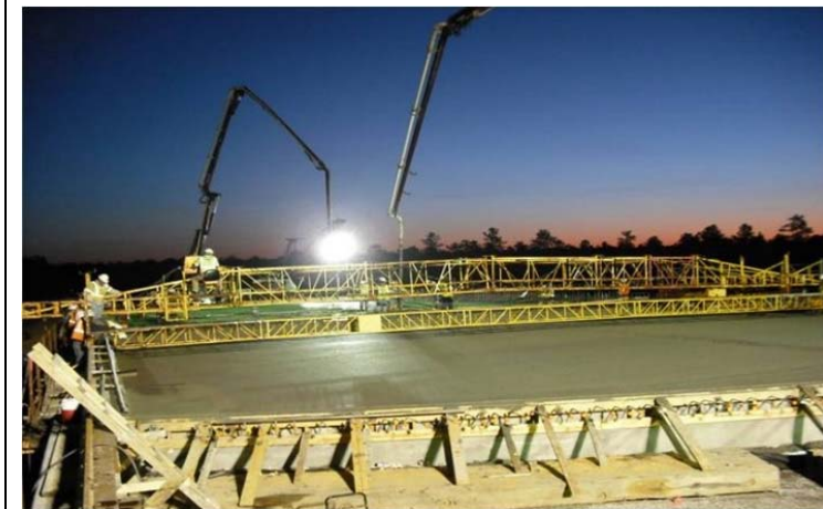
Bridge Deck Pour
